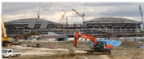
▲ 市立吹田サッカースタジアム施工現場
