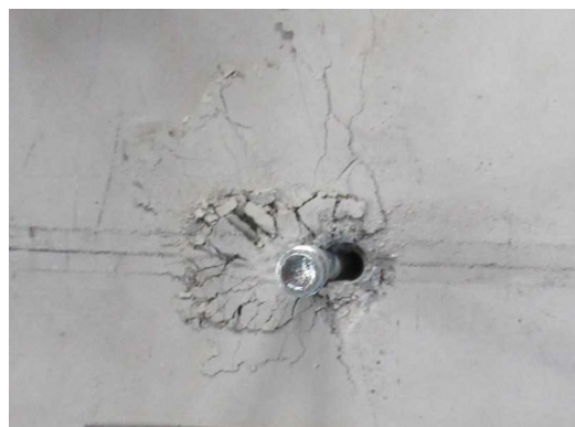
図7-6. 実体せん断 TP II-1210破壊形態
