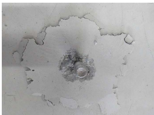
図7-4. 実体引抜 STP II-1210破壊形態
